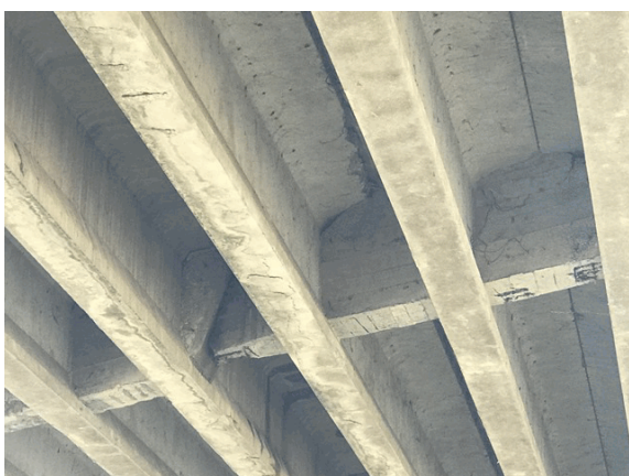
Foto 24: Travi e traversi della campata centrale, ove presente dilavamento
