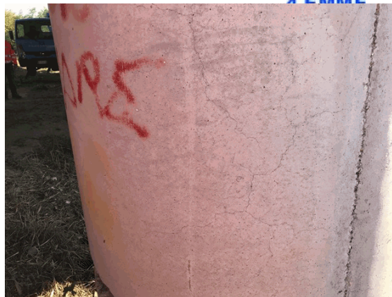
Foto 10: Pilastro monte pila sinistra - lesioni capillari
