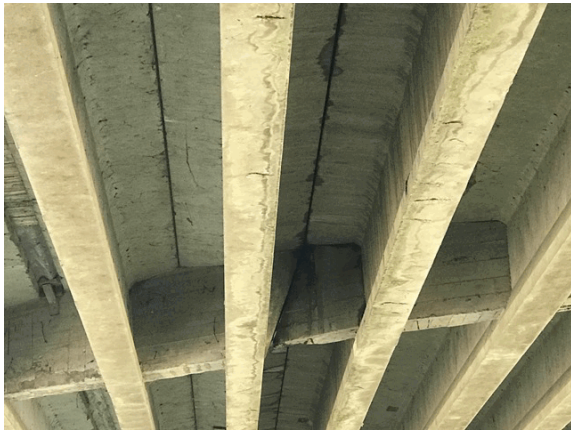
Foto 20: In corrispondenza dei giunti tra gli impalcati e nei punti di infiltrazione dell'acqua
