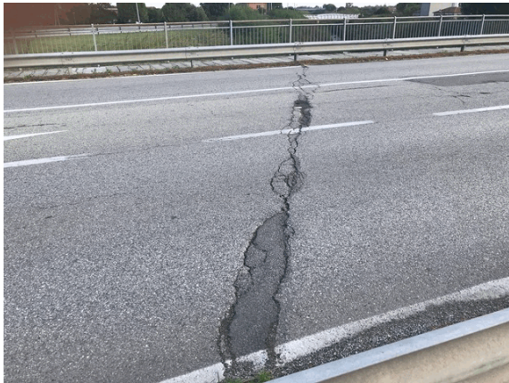
Foto 13: Lesione sulla pavimentazione in corrispondenza dei giunti longitudinale e trasversali
