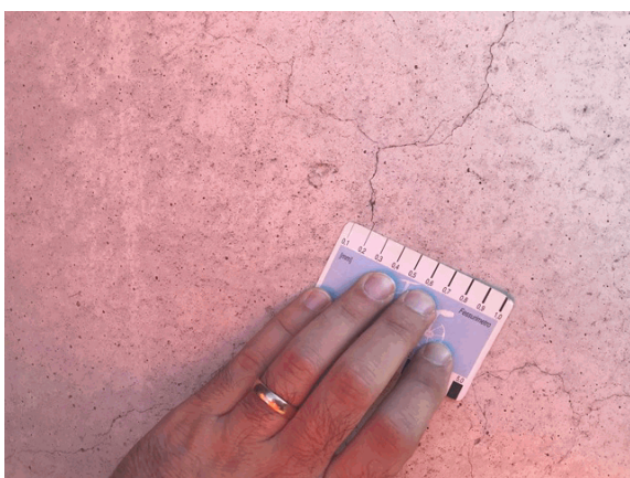
Foto 11: Pilastro monte pila sinistra - lesioni capillari
