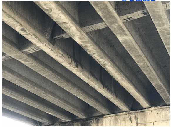
Foto 21: In corrispondenza dei giunti tra gli impalcati e nei punti di infiltrazione dell'acqua
