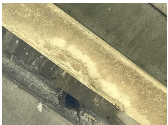
Foto 25: Travi e traversi della campata centrale, ove presente dilavamento
